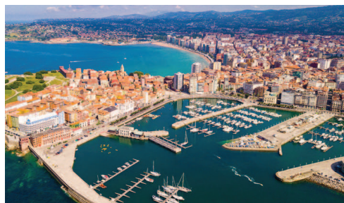
Vista aérea existente de una zona de la actuación.
