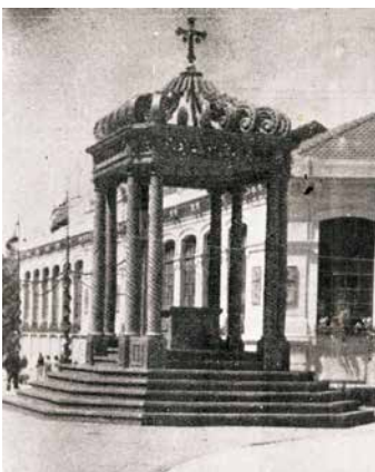
Baldaqino instalado en la plaza del Seis de agosto (1939).
