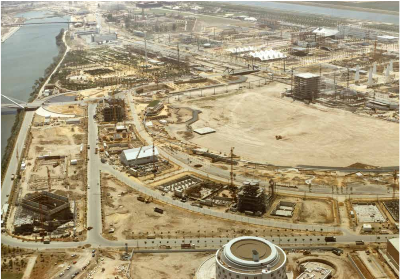
Recinto de la Exposición Universal de Sevilla de 1992 en construcción.
