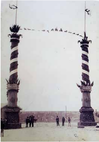
Columnas monumentales levantadas por la «Sociedad Moreda y Gijón» para la visita real de 1900.
