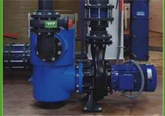
Detalle del sistema de bombeo, con la bomba y el prefiltro.
