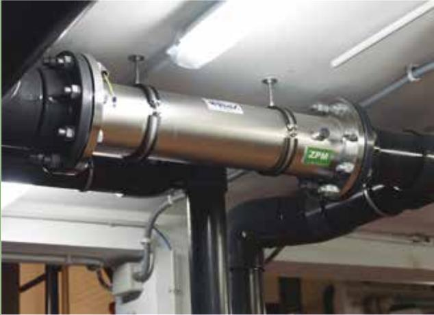
Detalle del mezclador estático ZPM para la inyección de coagulante-floculante.
